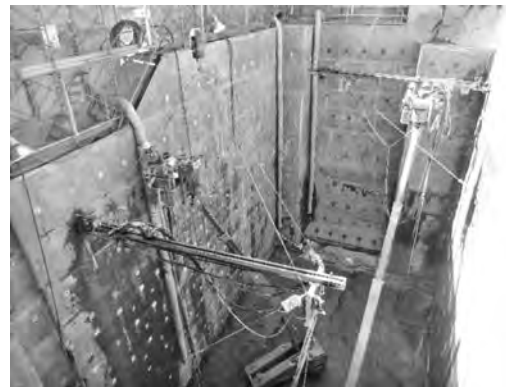
写真一七 増しロックボルト施工状況 (立坑)
