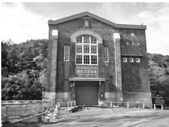
写真一3 補修完了全景
