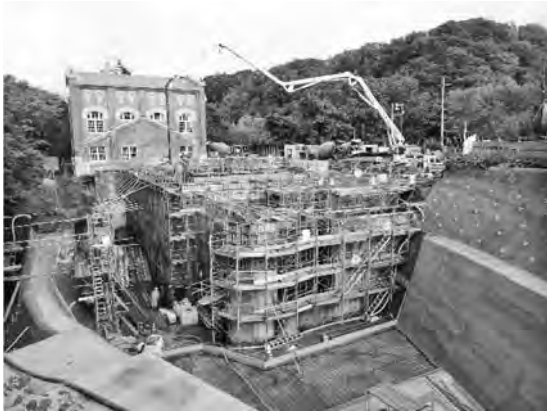
写真—8 躯体構築状況
