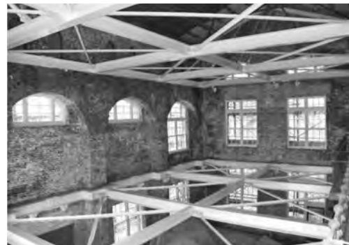
写真—1 耐震補強完了全景（内側）
