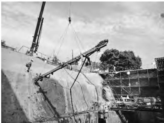
写真一六 増しロックボルト施工状況 (額縁)
