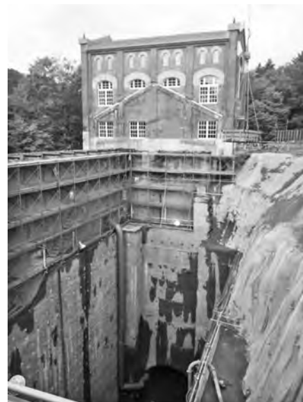
写真一4 立坑掘削状況
