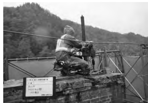
写真—2 アラミドロッド施工状況
