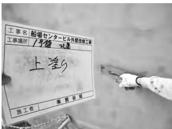
写真-10 下地仕上 (上塗り)
