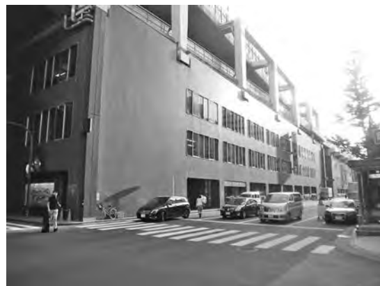
写真-1 一般部の改修前
