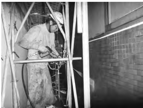
写真—5 外壁高圧洗浄
