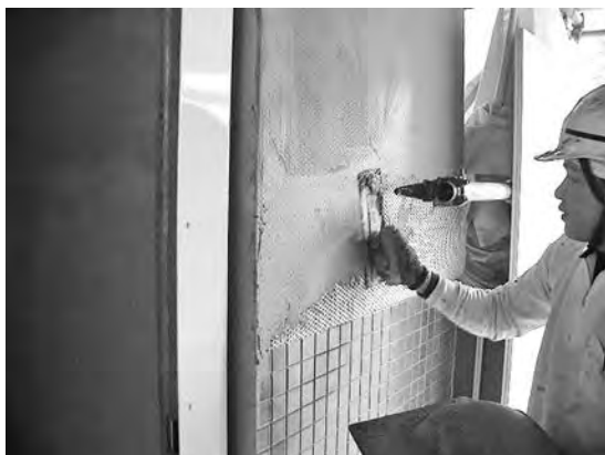
写真—6 下塗り・ネット貼付け
