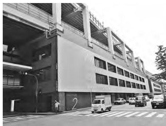
写真-2 一般部の改修後
