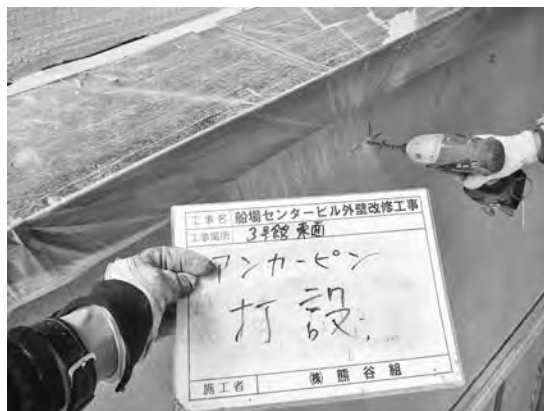
写真—8 アンカーピン打設
