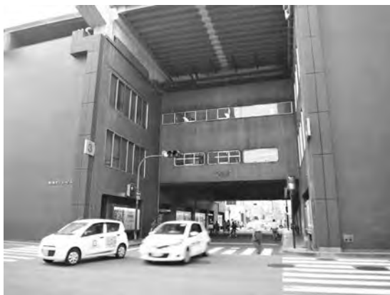
写真—12 筋部の改修前
