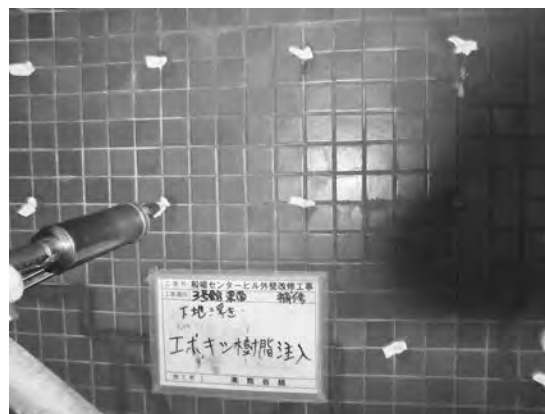
写真—4 エポキシ樹脂注入
