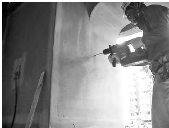
写真—7 アンカーピン用の穴の穿孔
