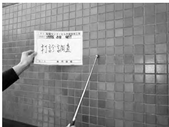
写真—3 タイル打診検査
