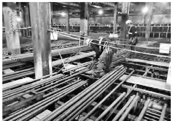
写真一 8 従来作業状況
