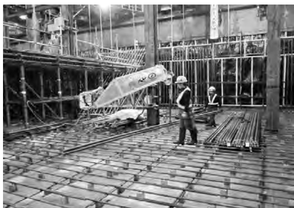
写真一 7 本ロボット使用作業状況
