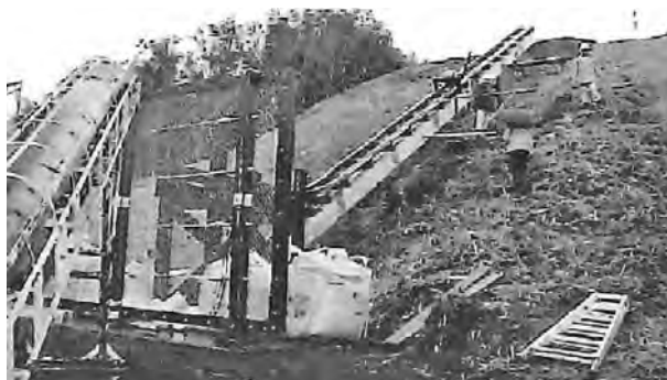
写真—3 落下物防止柵の衝突試験
