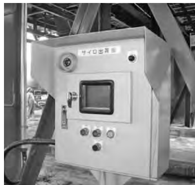
写真 6-28 サイロ自動出荷盤
