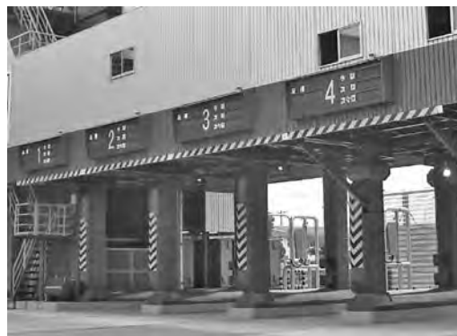
写真 6-29 誘導電光掲示板
