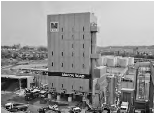
写真 6-32 NAP EBD-1608-9351D(八王子市に設置) EBD⇒Euro(ユーロ)タイプBDシリーズ 1608⇒アスファルトプラント乾燥能力1.6t×60B/h +リサイクルプラント能力80t/h 9351⇒合材サイロ90ton×3基 +サージビン50ton×1基 D⇒Deodorizer(脱臭装置)
