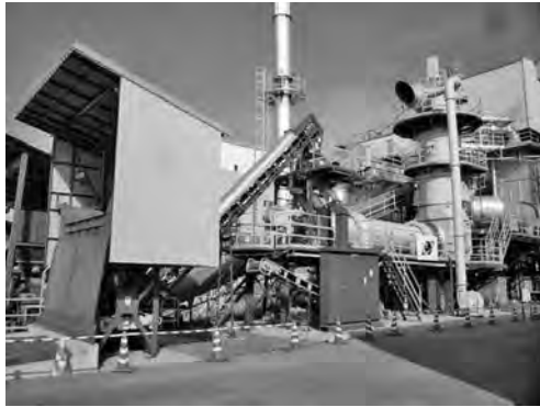
写真 6-36 固形燃料燃焼システム全景
