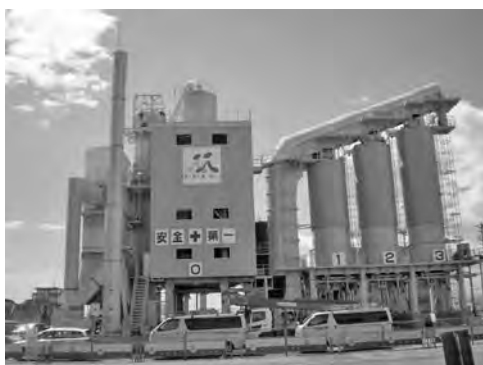
写真 6-39 MBD-1600 + TOP α80 + 360 型サイロ (前橋市に設置)
