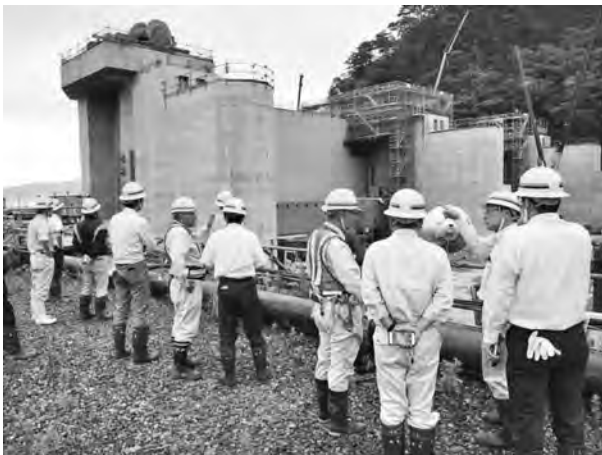
写真—2 水門2径間（右岸側）
