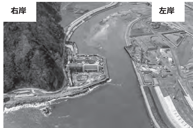
写真—1 施工箇所全景（2017 年 3 月）
