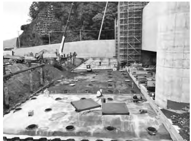
写真—3 鋼管ソイルセメント杭（ガンテツパイル工法）
