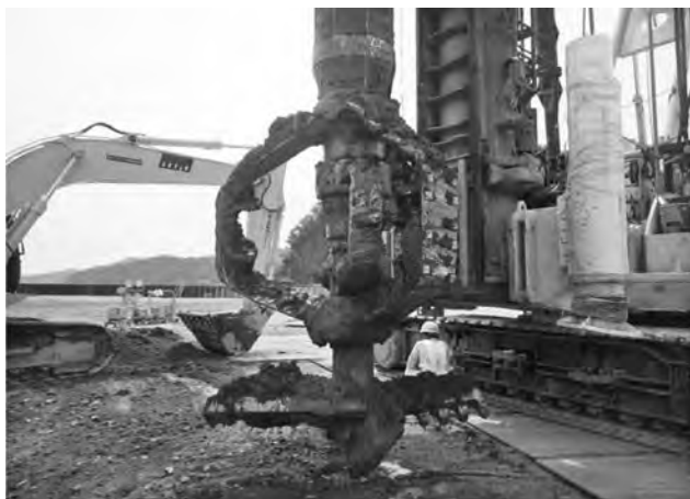
写真—5 エボコラム攪拌翼 (φ 2000 mm)
