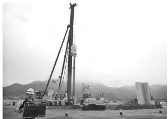
写真—4 エポコラム施工状況
