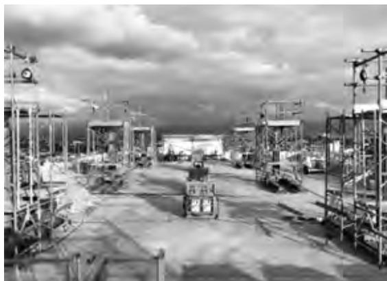
写真一三 屋上階 リフトアップ装置配置状況
