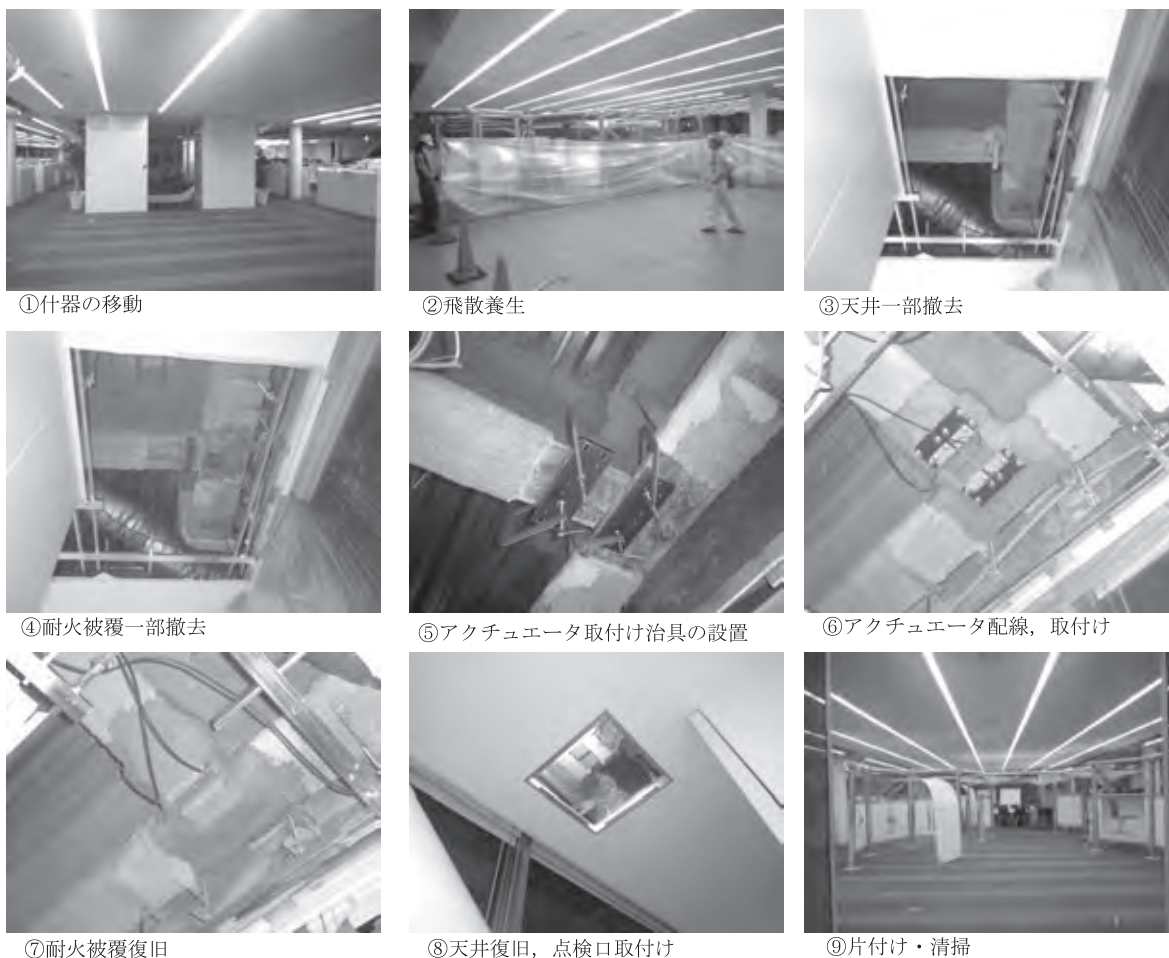
図一六 施工状況の例
