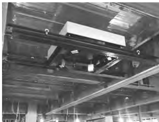
写真-1 床振動制御用動吸振器の例
