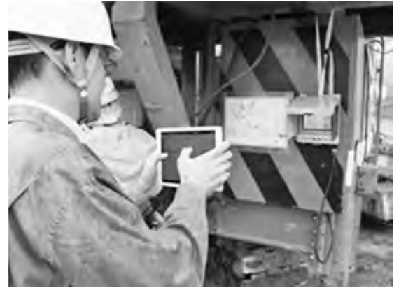
写真—1 既成杭工事記録写真撮影状況
