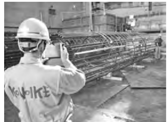
写真—2 場所打ち杭配筋写真撮影状況
