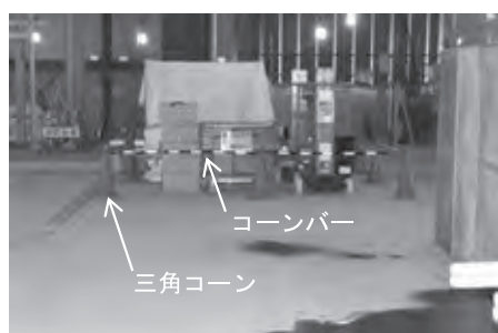
図-2 建築現場の一般的な作業環境
