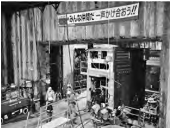
図—13 R-SWING 機横引状況
