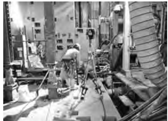
図—15 セグメント組立状況
