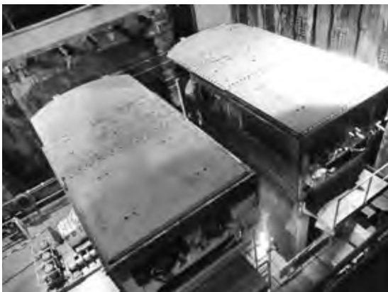
図—14 R-SWING 機接合状況
