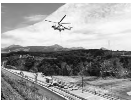
写真ー3 送り出し基地
