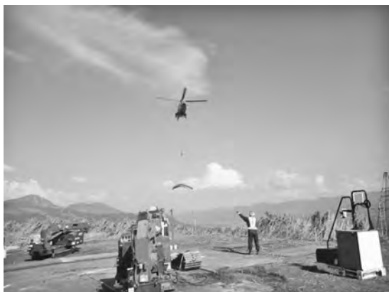
写真—6 ヘリコプターからの荷受け作業
