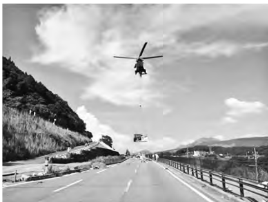
写真—5 送り出し基地での地切の瞬間
