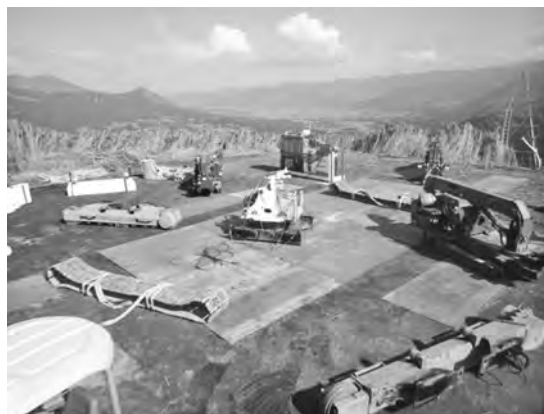
写真一9 空輸後の輸送基地
