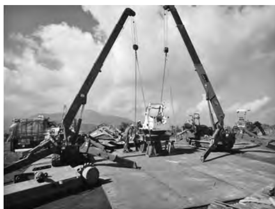
写真一10 輸送基地での組立作業
