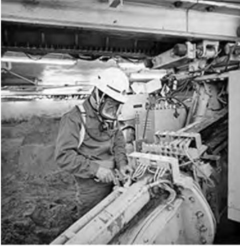
写真—8 ヘリウム混合ガス使用状況
