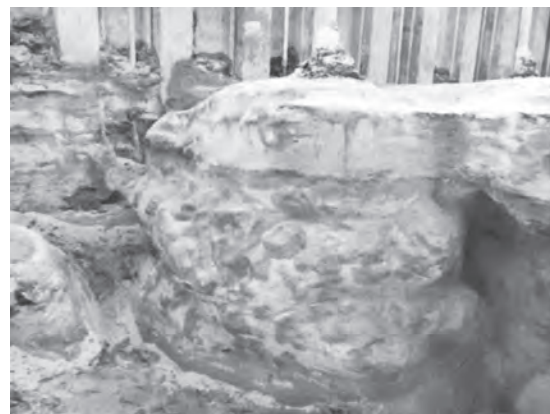
写真一 3 改良体（振動あり）
