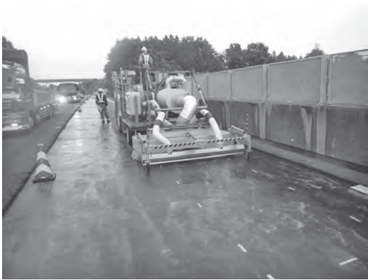
写真一 現場施工前状況
