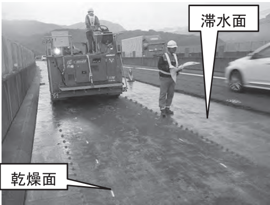
写真一 現場施工後状況
