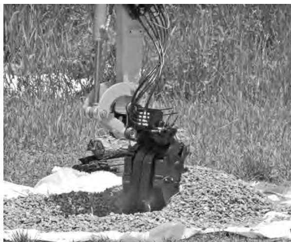
写真—6 土砂掘削
