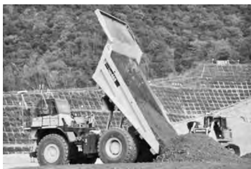
写真—7 自動化ダンプトラックと自動化ブルドーザの連携作業
