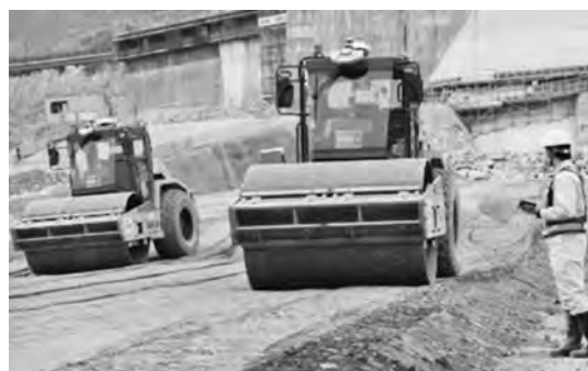
写真一3 2台の振動ローラによるコア材自動転圧
