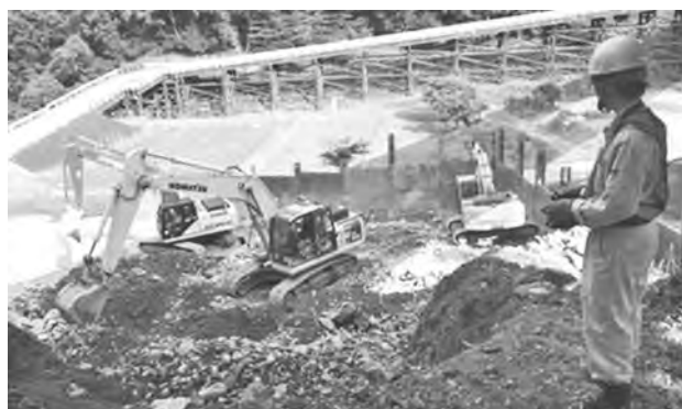
写真一 4 本装置の利用状況
