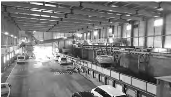
写真-1 坑外ズリストックヤード
