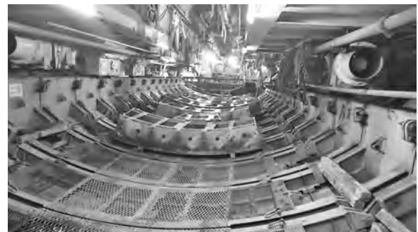
写真-5 No2 台車 内型枠脱型装置から坑口側
