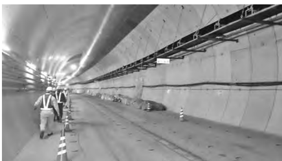
写真-3 上部インバート施工終了部
