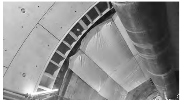
写真-4 シールド終端部-SENS 開始部接続状況
