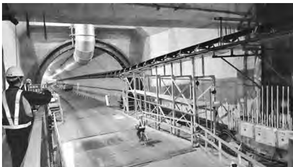
写真-2 発進立坑-シールド部坑口状況
