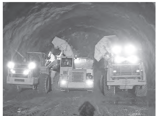
写真-2 高速ずり出し (2台積込み)
