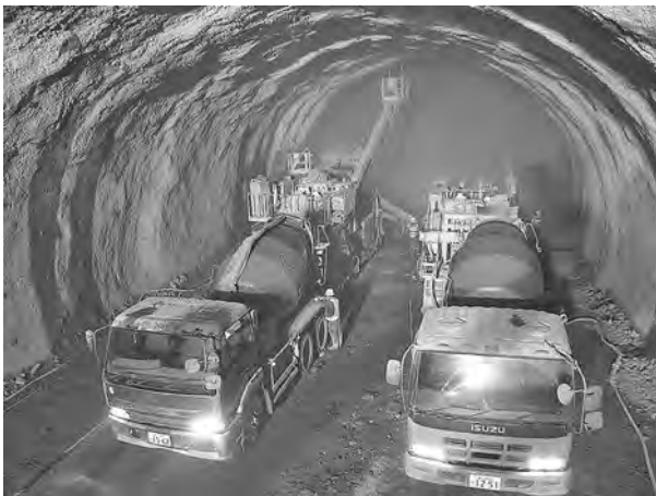
写真一 3 吹付け時間短縮 (2台吹付け)
