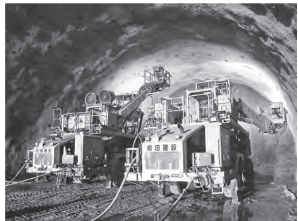
写真-1 穿孔速度向上 (2台穿孔)
