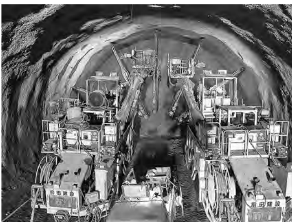
写真一 4 ロックボルト時間短縮 (2台施工)
