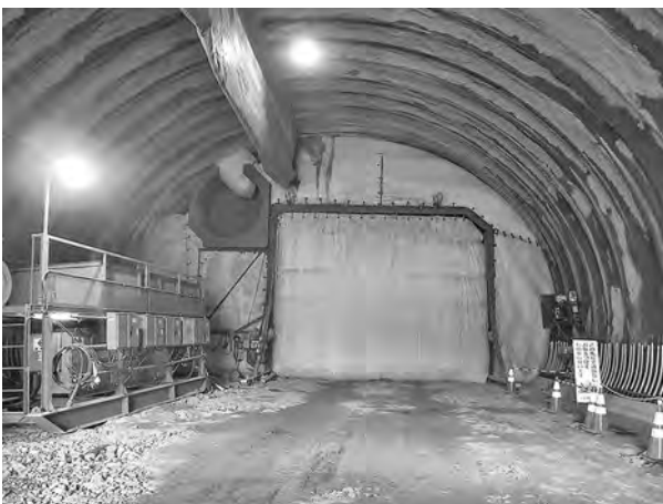
写真—5 マルチバルーン（飛び石防護時）
