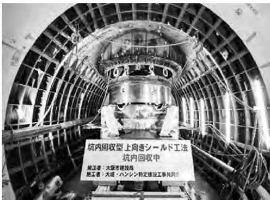
写真一5 上向きシールド機坑内回収状況③
