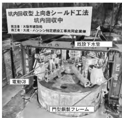
写真—2 マシン吊降ろし設備設置状況
