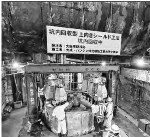
写真一3 上向きシールド機坑内回収状況①
