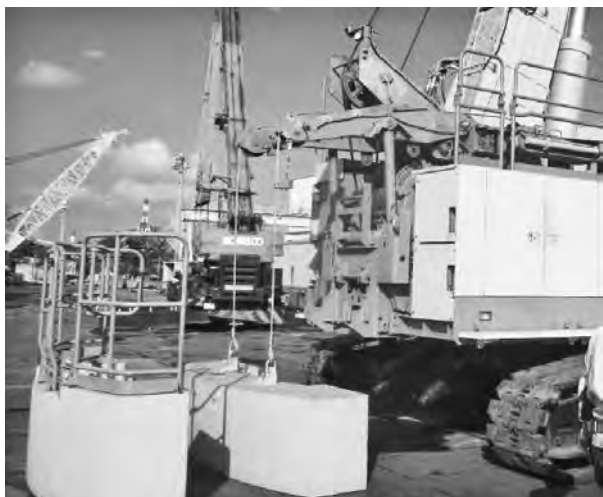
写真—8 カウンタウエイト自力脱着装置
