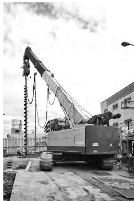
写真一 3 プレボーリング工法
