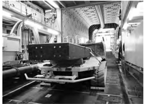
写真一五 セグメント坑内運搬状況
