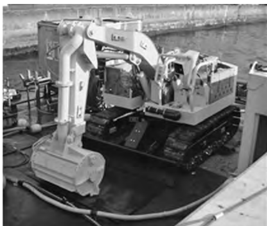
写真—1 本遠隔操縦 BH
