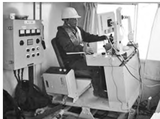
写真—3 遠隔操縦状況（体感装置）
