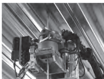
吊ボルト挿入
