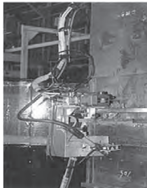
'92 鉄骨柱溶接ロボット
