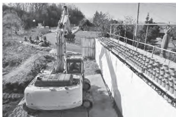
写真-1 音響管付二重防音壁設置状況
