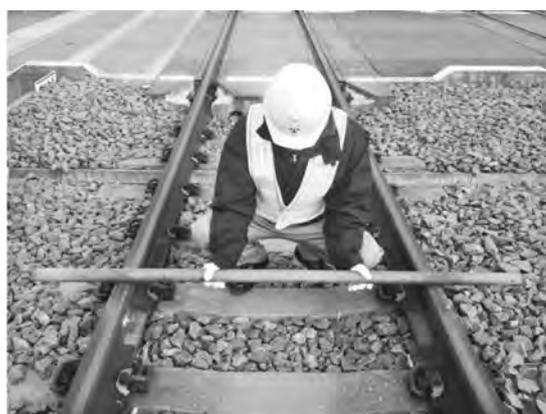
写真一八 単管パイプによる不正落下 (短絡)<sup>※12</sup> 体験研修
