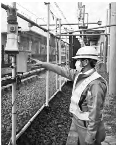
写真一四 列車防護訓練 (工事用列車停止装置)
