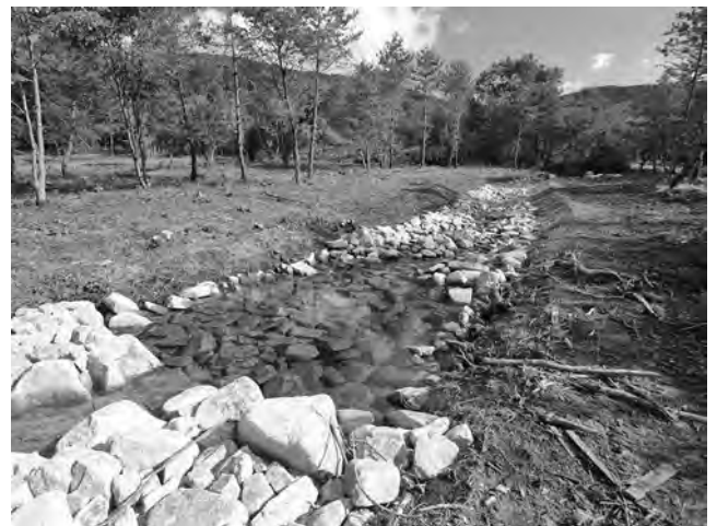
写真二 完成した導水路 (2007～2008年)
