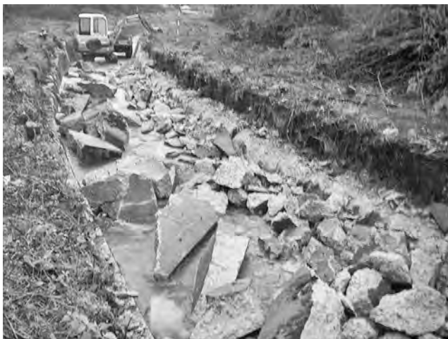
写真一 霧ヶ谷湿原の中央にあった排水路コンクリート護岸の除去 (工事期間の2007～2008年)
