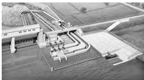
図—4 魚道上流側の網場(回収に集塵船を活用)
