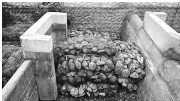
写真—4 カゴ詰め玉石工の設置状況
