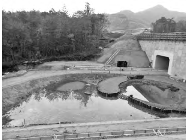
写真—5 完成直後のビオトープ（平成 25 年 12 月）
