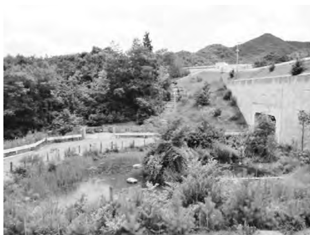
写真—6 完成後4年目のビオトープ（平成 29 年 7 月）
