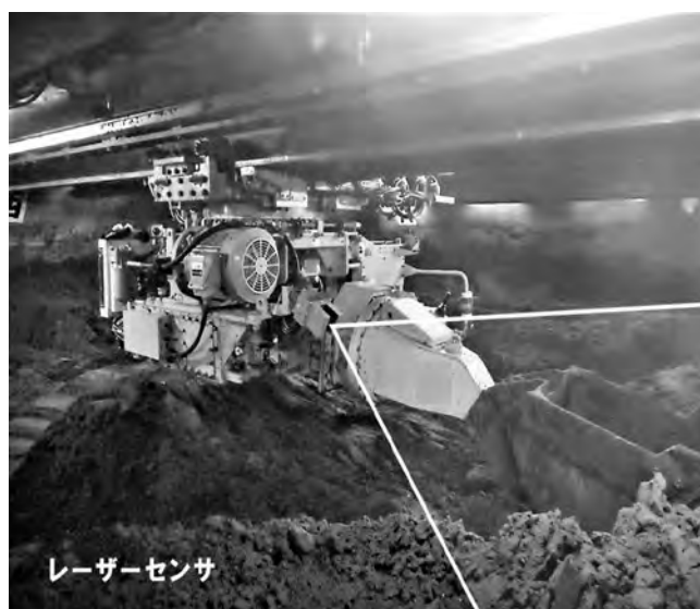
図-1 レーザーセンサを搭載した掘削機
