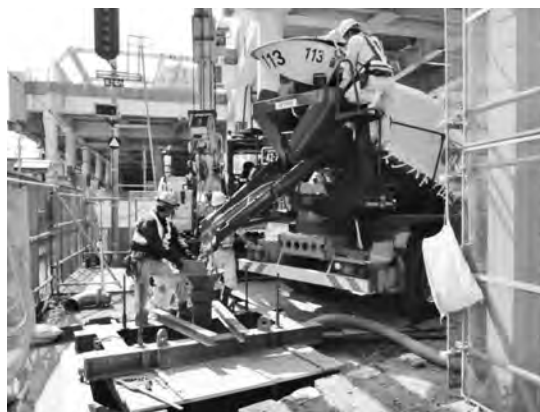
写真—9 コンクリート打込み状況
