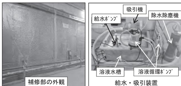
写真一四 建築物の屋内壁面に対する施工状況
