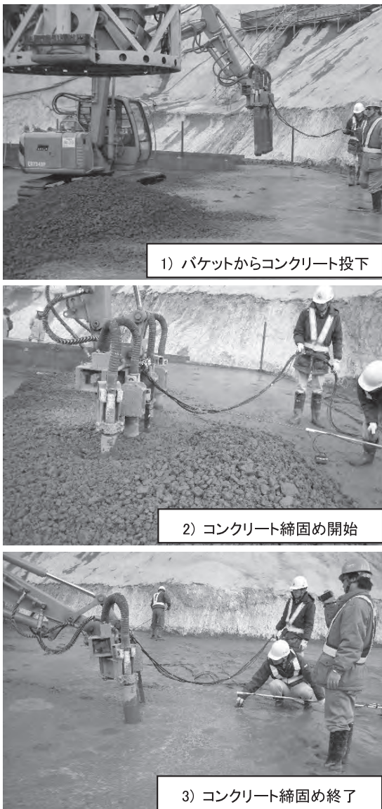
図一1 ダムコンクリートの締め固め状況変化
