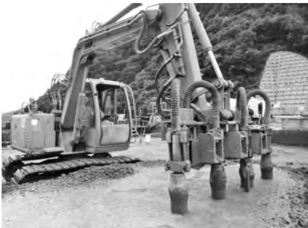
写真—1 ダムコンクリート締固め状況
