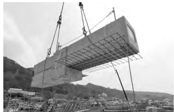
写真-8 PCaPC 梁下の定着筋
