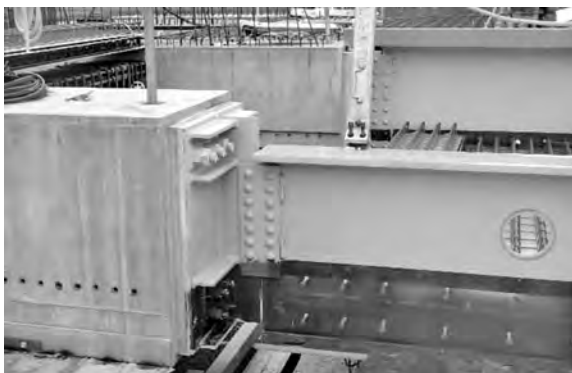
写真-7 PCaPC 梁と鉄骨部材の取合い
