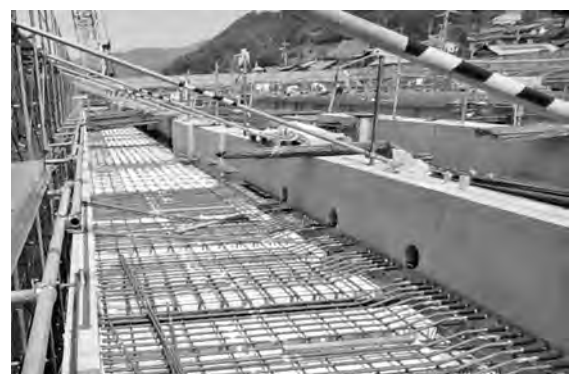
写真-10 PCaPC 梁側面の定着筋
