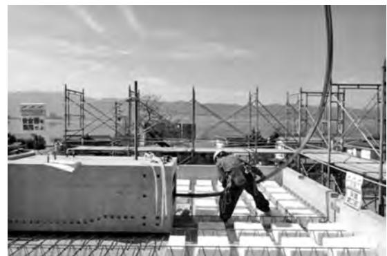
写真-9 PC 鋼線挿入状況
