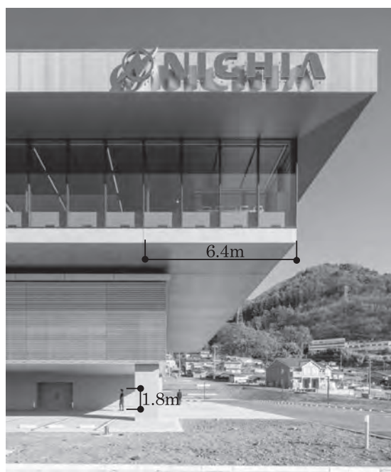
写真一 2 6.4 m 跳出し見上げ
