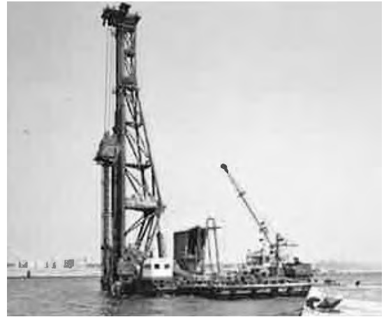
写真一 杭打船
