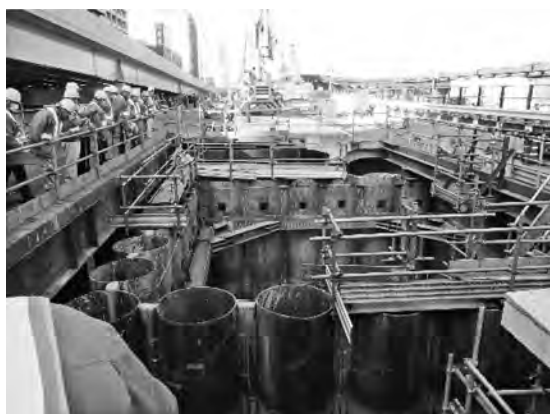
写真—3 現場見学（橋脚 基礎部）
