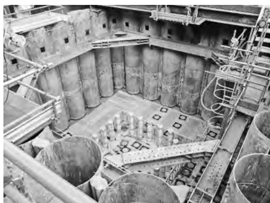
写真—4 現場見学（橋脚基礎 内部）
