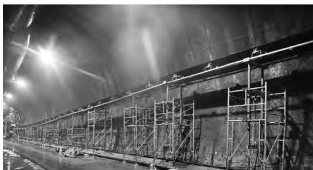
写真一1 連続ベルトコンベア昇降装置 設置状況
