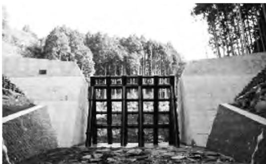
写真一五 透過型の砂防堰堤の整備事例 (鏡子沢)
