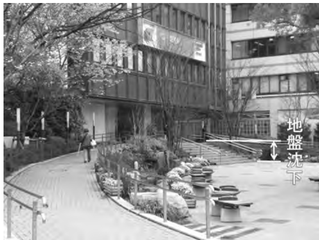
写真—1 江戸川区役所でも1m以上の地盤沈下
