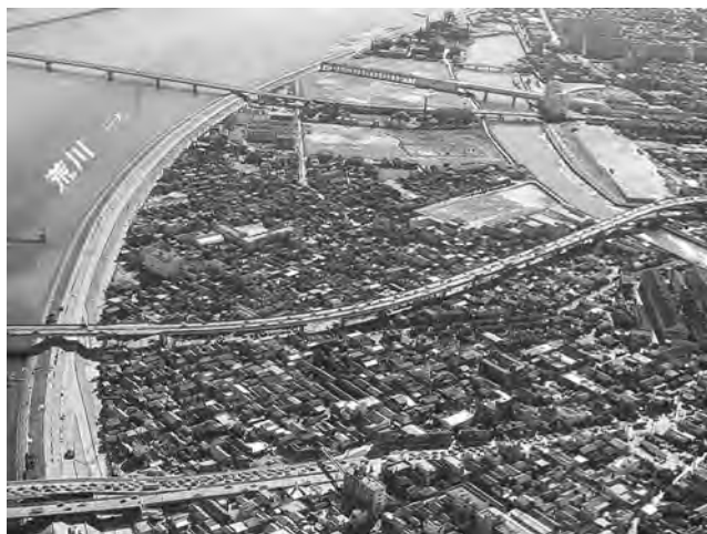
写真—5 【施工前】大島小松川地区
