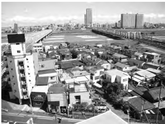
写真一 3 平成 20 年 8 月【施工前】
