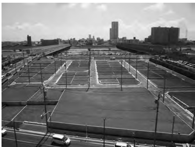
写真一 4 平成 29 年 8 月【施工後】
