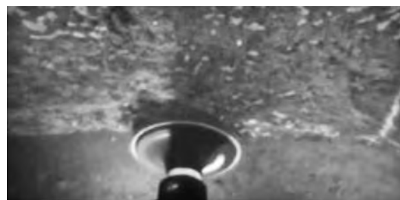
写真—7 壁面清掃状況
