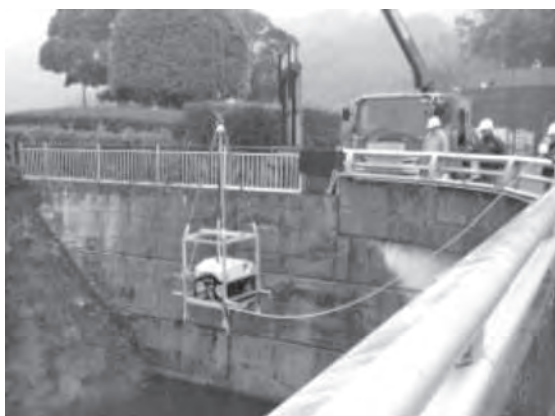
写真-3 吊りケージによる本ロボット投入状況
