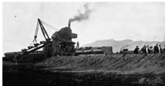
写真—3 遠賀川改修のエキスカ
