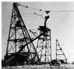
写真—17 常願寺川改修
