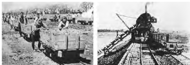
写真一九 人力掘削と機械掘削
