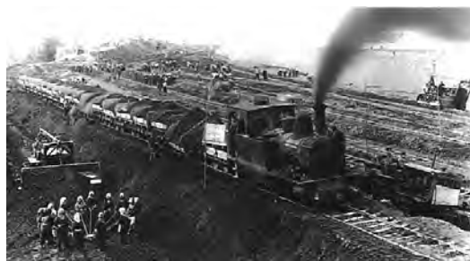
写真—18 利根川堤防復旧工事
