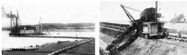
写真一八 石狩川の浚渫船とエキスカ
