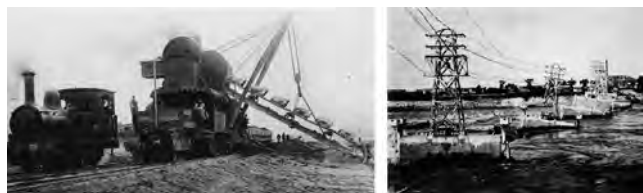
写真—7 新潟鉄工製エキスカと自在堤倒壊
