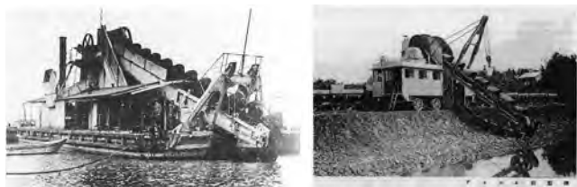
写真一〇 浚渫船
