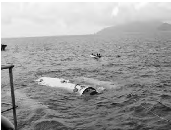
写真—4 口之島沖の実証試験海域に設置中の本実証試験機
