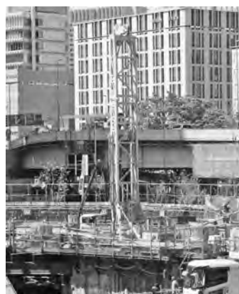
写真—5 東京都 温泉掘削 SSD-3000
