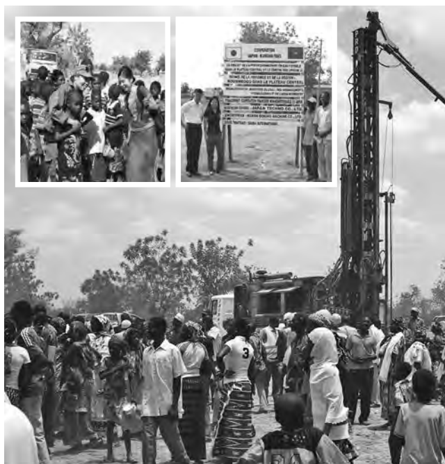
写真—3 ブルキナファソ：水井戸掘さく工事
