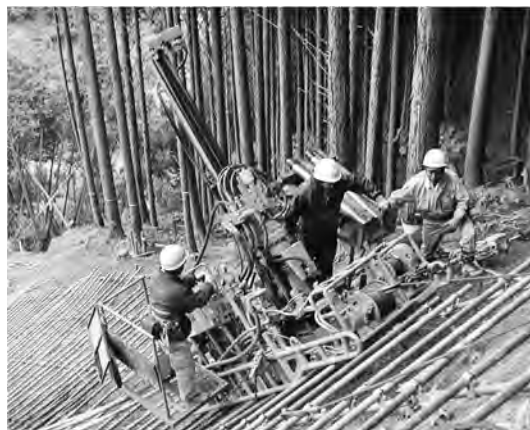
写真—1 法面補強での削孔と補強のためのロックボルト打ち込み
