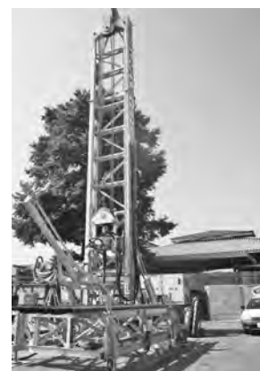
写真—6 埼玉県 温泉掘削 SSD-3000
