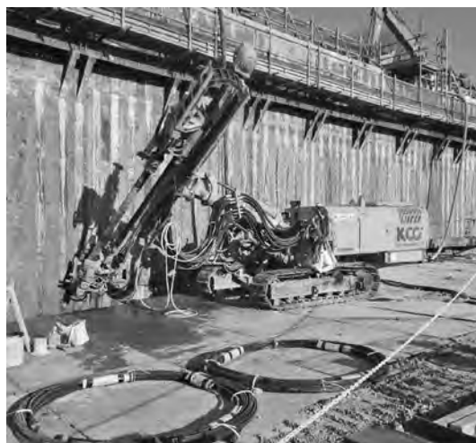
写真—2 東京都渋谷区：アンカー工事
