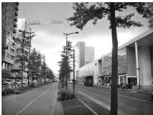
写真—25 開発工事の完成状況
