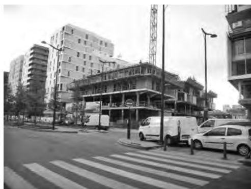
写真—26 都市開発の工事状況
