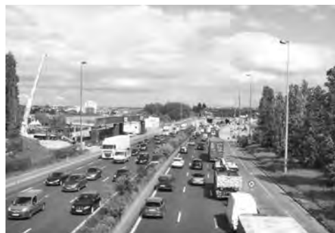
写真—27 A4 高速道路および施工場所の状況
