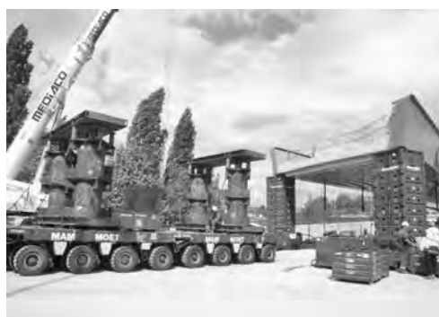
写真—29 橋梁を運搬するユニットキャリア
