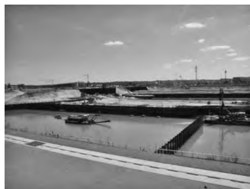
写真—31 第3ターミナルの施工状況
