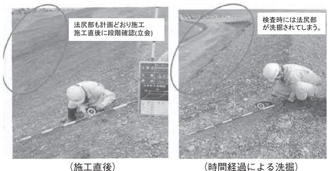
図一 4 養浜工事での出来形管理の状況
