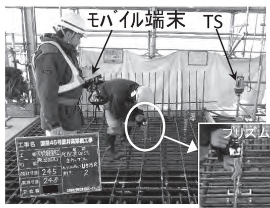
写真三 PC 鋼材配置検測状況
