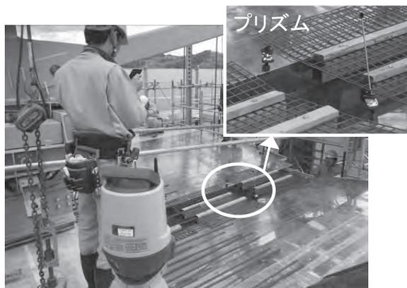
写真二 型枠セット測量状況
