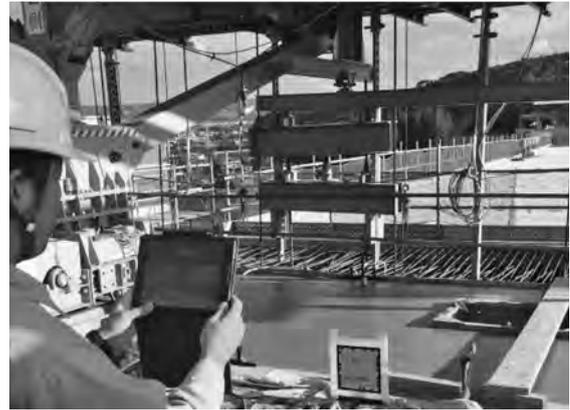
写真一6 仕上げ面の平坦性確認状況
