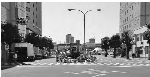
写真—3 中央分離帯の撤去
