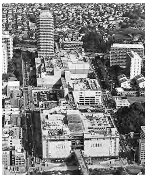
写真—2 オーロラシティ商業棟完成時
