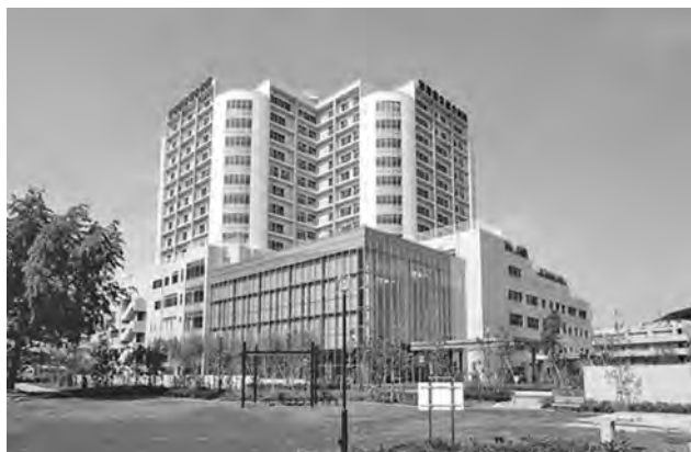
写真—4 地域との合意形成が求められた大規模建築工事事例
