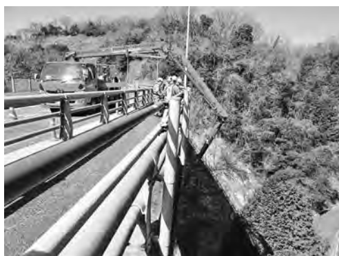
写真—3 ブームの操作状況（橋梁上部）
