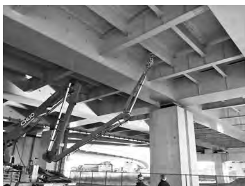
写真—5 ブームの操作状況（橋梁下）
