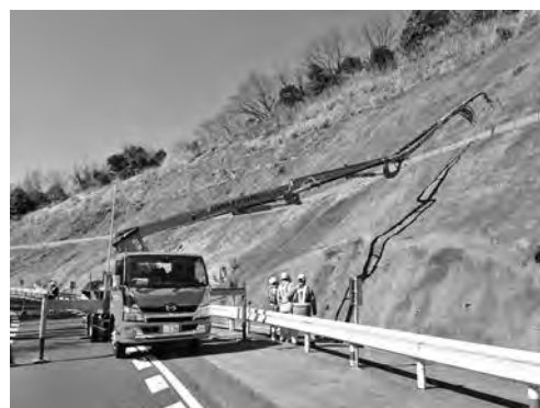
写真—6 法面への適用状況
