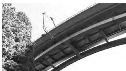
写真—4 ブーム先端の取り回し状況
